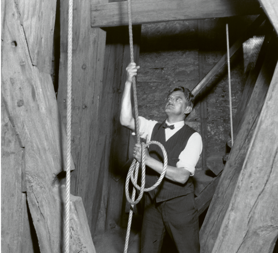
39 Glöckner bei der Arbeit im Gebäk eines Glockenturms. Foto: Lothar Jeck, um 1938.
