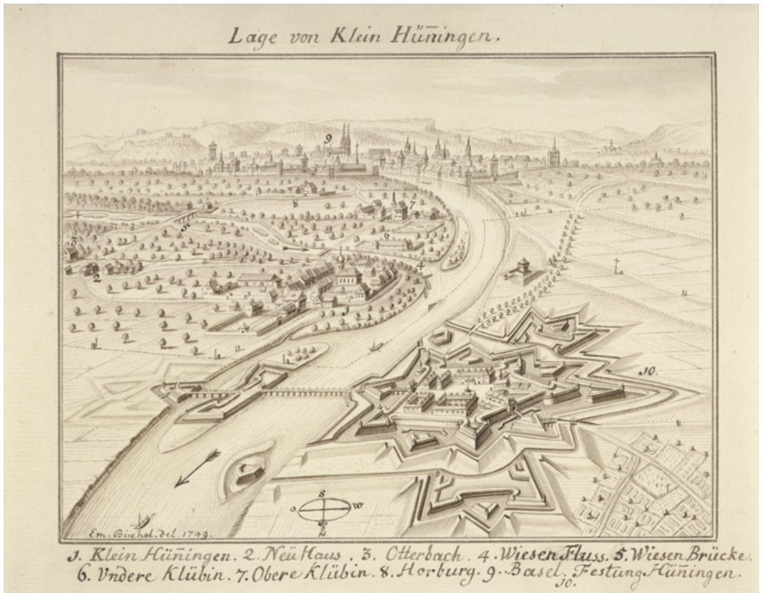
74 «Lage von Klein Hüningen», Zeichnung von Emanuel Büchel, 1749. — Gegenüber der Festung von Vauban, mit Brücke und Brückenkopf, liegen Kleinhüningen und die Mündung der Wiese in den Rhein. Basel ist im Hintergrund dargestellt.
