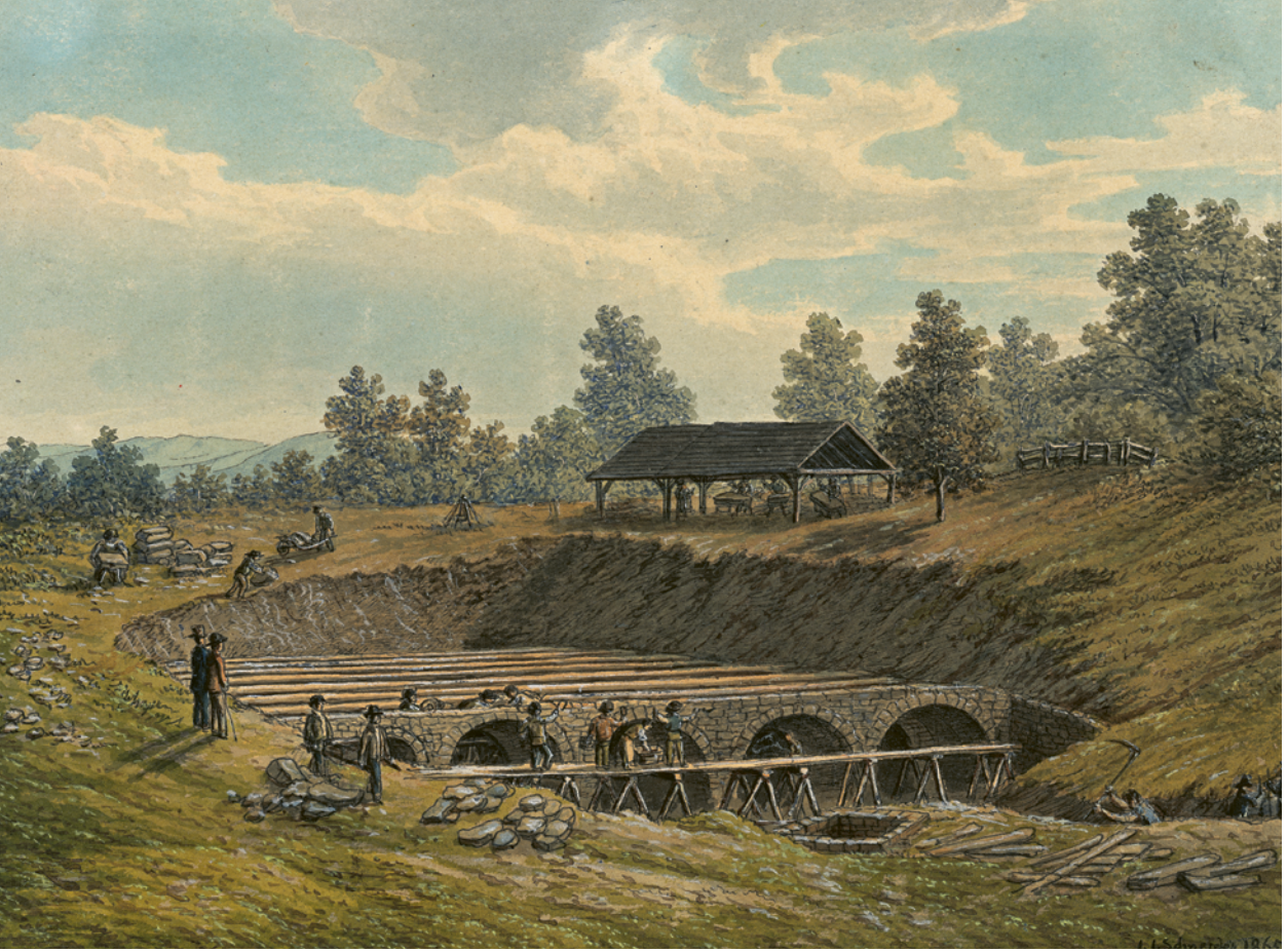
102 Bau des Wasserreservoirs der Grellinger Wasserversorgung auf dem Bruderholz, Aquarell von Johann Jakob Schneider, 1865.
