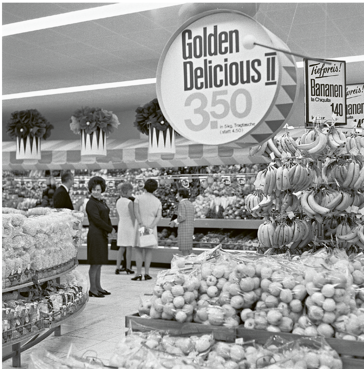
121 In der Migros Rebgrasse, 1968.
