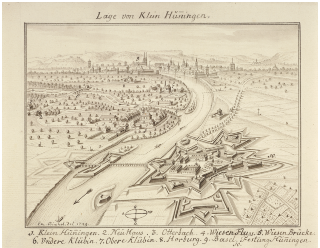
74 «Lage von Klein Hünningen», Zeichnung von Emanuel Büchel, 1749. — Gegenüber der Festung von Vauban, mit Brücke und Brückenkopf, liegen Kleinhünningen und die Mündung der Wiese in den Rhein. Basel ist im Hintergrund dargestellt.
