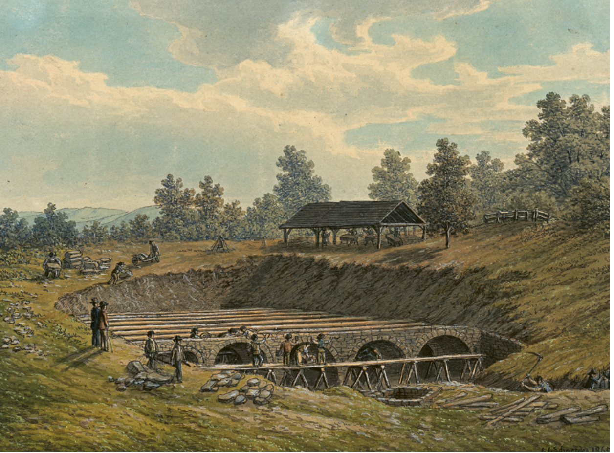
102 Bau des Wasserreservoirs der Grellinger Wasserversorgung auf dem Bruderholz, Aquarell von Johann Jakob Schneider, 1865.
