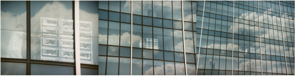
63 Biologie-Hochhaus von Ciba-Geigy in Basel.
