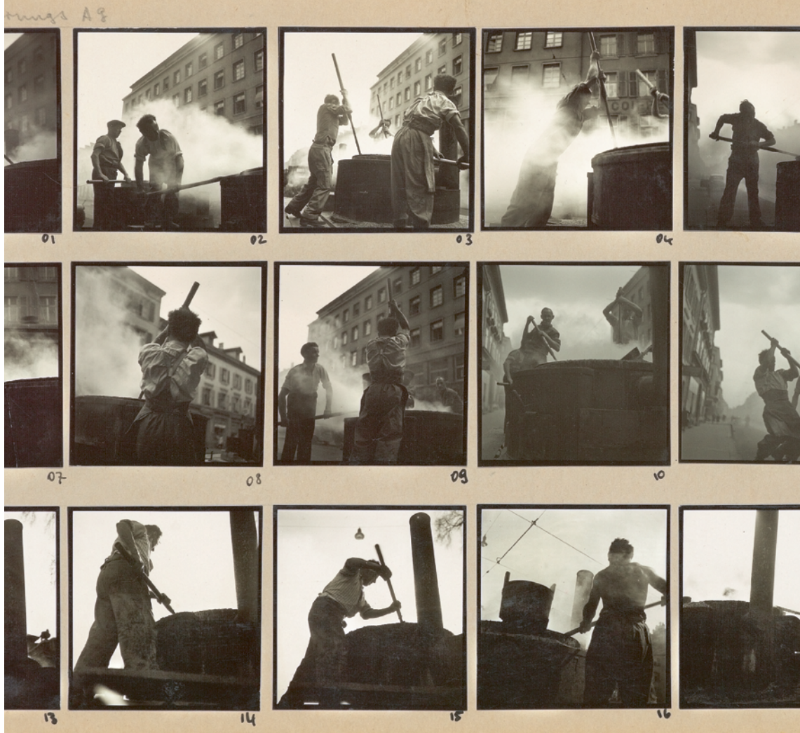
7 Asphaltarbeiten und Strassenbau in Basel, zwischen 1960 und 1970. — Basel erlebte in den 1960er-Jahren einen Bauboom. Die daran beteiligten Arbeiter waren oftmals Saisoniers oder Grenzgänger, viele stammten aus Italien oder dem Elsass.
