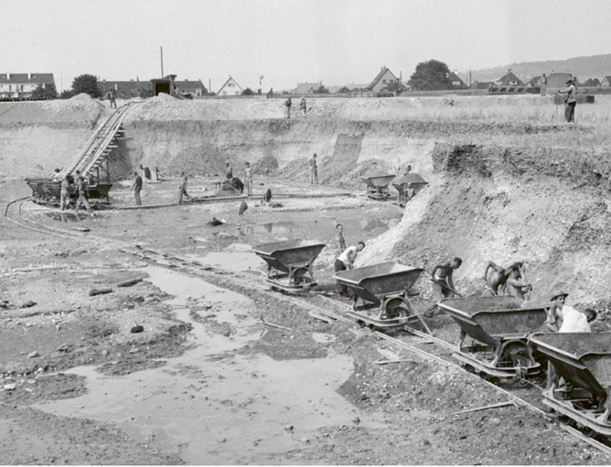
81 Aushub des Hafenbeckens II.
