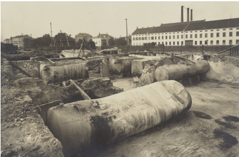
↑ 19 Schaulustige beim Brand des Petroleumkellers der «Basler Lagerhausgesellschaft». Foto: Foto Hoffmann, August 1910. | ← 20 Das ausgebrannte Lager des Petroleumkellers. Foto: Foto Hoffmann, August 1910. —
