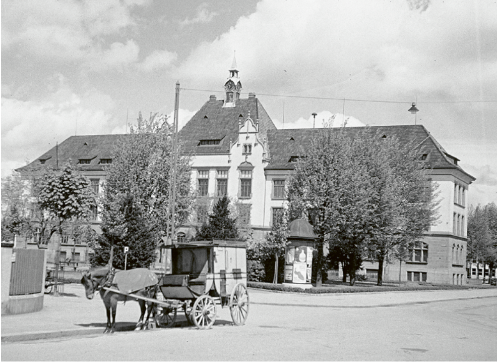
63 Das 1902 eröffnete Gotthelfschulhaus. Foto: Bernhard Wolf-Grumbach, undatiert. — Um die Wende zum 20. Jahrhundert wurden eine Vielzahl neuer, moderner Schulhäuser erbaut. Sie dokumentierten die Bedeutung der Schulbildung auch in ihrer Architektur. Noch gehörten auch Droschken zum Stadtbild. Sie mussten jedoch sukzessive neuen Verkehrsträgern wie dem Tram Platz machen.
