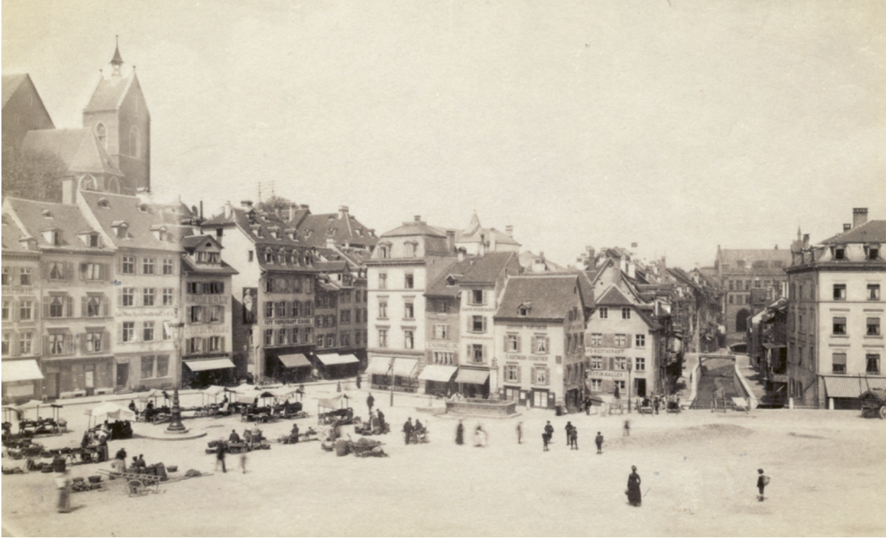
60 Der offene Birsig (rechts) vom Barfüsserplatz in Richtung Hauptpost. Foto: Foto Wolf, um 1896. — Viel zu lange blieb der Birsig in der Innenstadt Krankheitsherd und Schandfleck. Ab 1887 erfolgte endlich die Korrektur. Zunächst verschwanden die Aussentoiletten an den Fassaden zugunsten von Balkonen und der Birsig bekam ein gemauertes Bett. Um 1900 war er vom Barfüsserplatz bis zur Schiffflände vollständig überdeckt. Auf der neuen Falknerstrasse fuhr nun das Tram.
