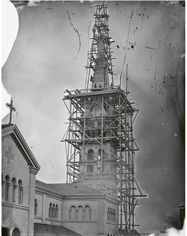
41 Turm der Marienkirche im Bau. Foto (Original beschädigt): Jakob Koch, ca. 1886. — Mehrere Männer (vielleicht Bauarbeiter, Bauleiter oder Auftraggeber) posieren auf dem Turm der Marienkirche, die 1886 fertiggestellt wurde. Sie war der erste katholische Kirchenneubau in Basel seit der Reformation.
