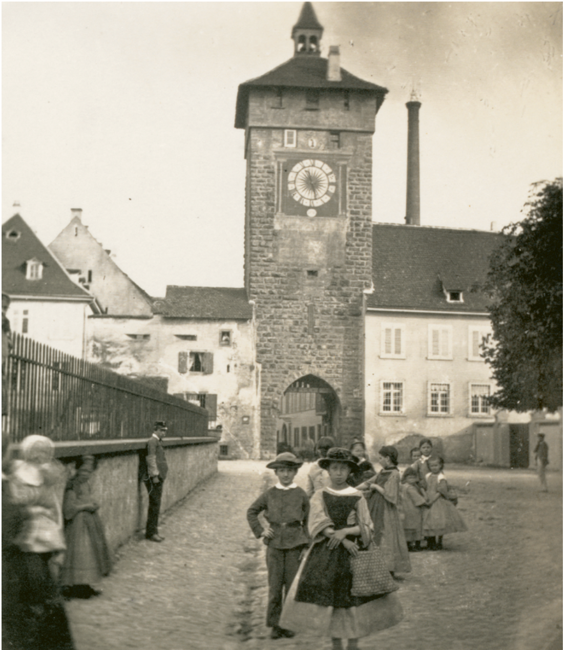
66 Das Bläseritor während der Entfestigung, anonyme Fotografie, 1860er-Jahre. — Der dem Tor vorgelagerte Graben wurde bereits 1833 aufgefüllt, das Tor und seine Vorwerke wurden aber erst 1867 abgebrochen. Hinter dem Tor zeigt ein Fabrikamin die Industrialisierung der Stadt an.
