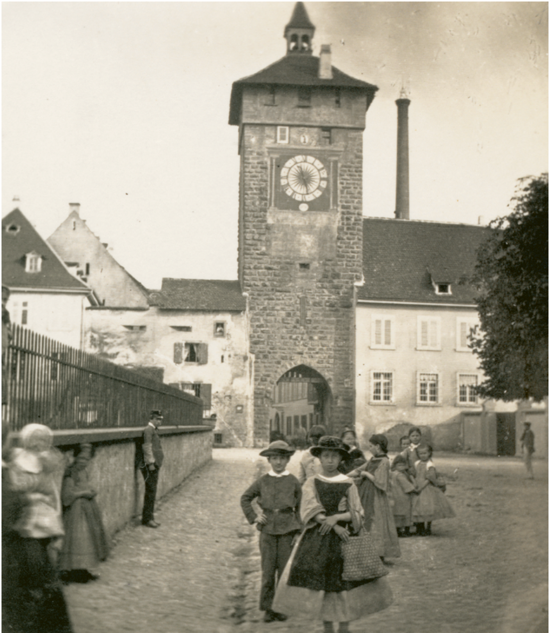
66 Das Bläseritor während der Entfestigung, anonyme Fotografie, 1860er-Jahre. — Der dem Tor vorgelagerte Graben wurde bereits 1833 aufgefüllt, das Tor und seine Vorwerke wurden aber erst 1867 abgebrochen. Hinter dem Tor zeigt ein Fabrikamin die Industrialisierung der Stadt an.
