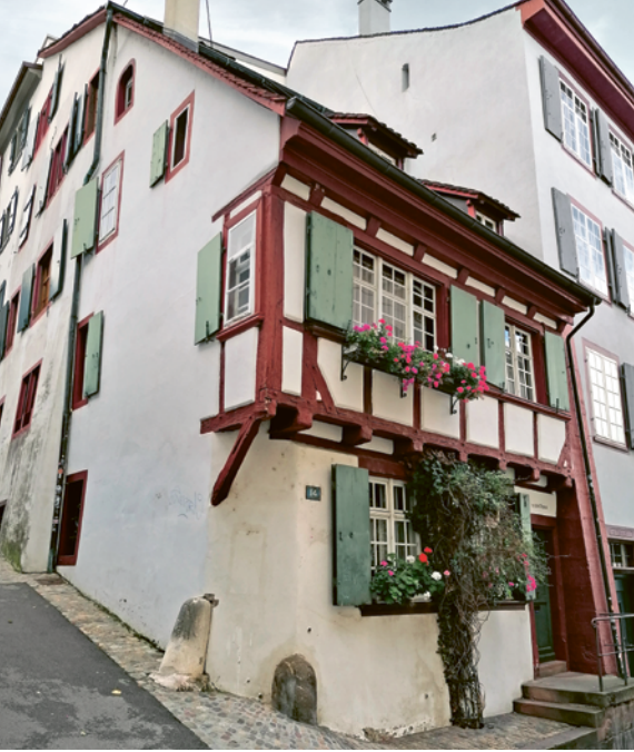
42 Haus «zum Brauer» (Rheinsprung 14), 15. Jahrhundert. — Auch im 15. Jahrhundert wurden in Basel noch Häuser gebaut, die nahezu vollständig Holzkonstruktionen waren. Dazu gehört dieses am Rheinsprung gelegene kleine Haus unterhalb der Martinskirche. Es diente zunächst als Wohnhaus für einen Kirchenkaplan. Kapläne, meist mit dem Dienst an einem Nebentalar betraut, hatten in etwa so hohe Einkünfte wie gut ausgebildete Handwerker und rangierten in der Mitte kirchlicher Positionen. Der Grundriss des Obergeschosses wurde in typischer Weise durch eine Auskragung vergrößert (KDS BS, Bd. 7, S. 358).
