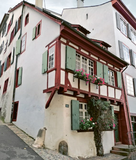
42 Haus «zum Brauer» (Rheinsprung 14), 15. Jahrhundert. — Auch im 15. Jahrhundert wurden in Basel noch Häuser gebaut, die nahezu vollständig Holzkonstruktionen waren. Dazu gehört dieses am Rheinsprung gelegene kleine Haus unterhalb der Martinskirche. Es diente zunächst als Wohnhaus für einen Kirchenkaplan. Kapläne, meist mit dem Dienst an einem Nebenalтарь betraut, hatten in etwa so hohe Einkünfte wie gut ausgebildete Handwerker und rangierten in der Mitte kirchlicher Positionen. Der Grundriss des Obergeschosses wurde in typischer Weise durch eine Auskragung vergrößert (KDS BS, Bd. 7, S. 358).
