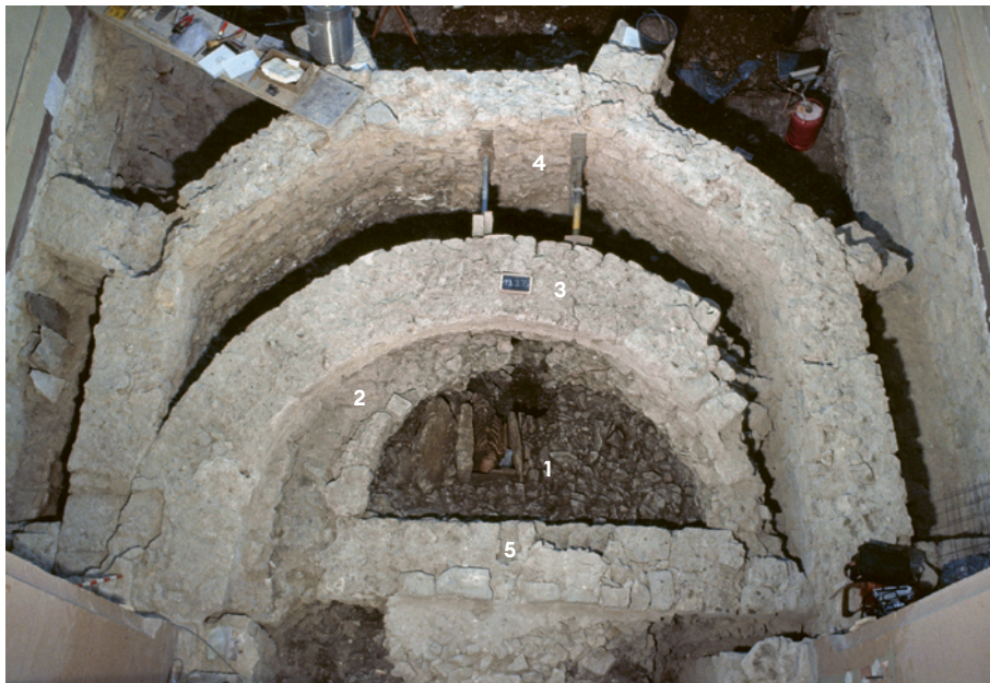
29 Ausgrabung im Chor der Chrischonakirche im Jahr 1975. — (1) Reste eines frühmittelalterlichen Plattengrabes, (2) Reste der karolingischen Apsismauer, (3) Fundament der romanischen Apsis, (4) Fundamente des hochgotischen Polygonalchors, (5) Ostwand der frühmittelalterlichen Kirche.
