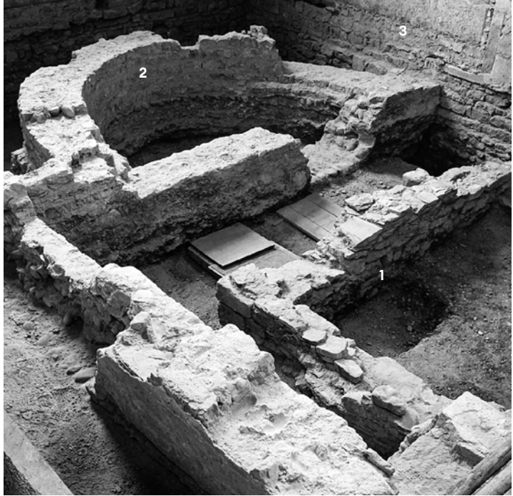
25 Ausgrabung im Chor der Peterskirche im Jahr 1962. — (1) Rechteckchor des Gründungsbaus (9./10. Jh.); (2) romanische Fundamente mit halbrunder Apsis (10./11. Jh.); (3) Fundamente und Mauerwerk des aktuellen gotischen Rechteckchors der Peterskirche (13. Jh.).
