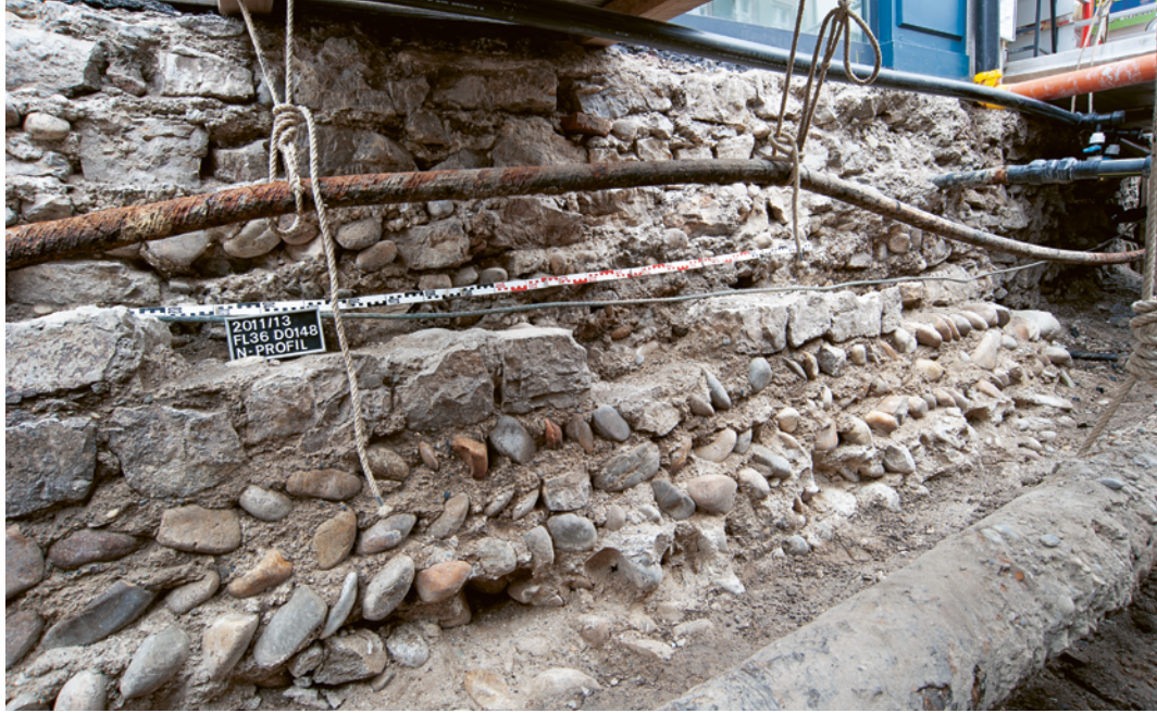
78 Fundamente der Häuser Spalenberg 58/60, Ausgrabung 2011. — Das den Häusern Spalenberg 58/60 vorgelagerte Fundament des Kernbaus ist auf der unteren Bildhälfte zu sehen. Zurückversetzt (über dem Massstab) liegen die jüngeren aktuellen Hausfundamente, in der Mitte ist das Fundament eines frühen Kernbaus erkennbar.
