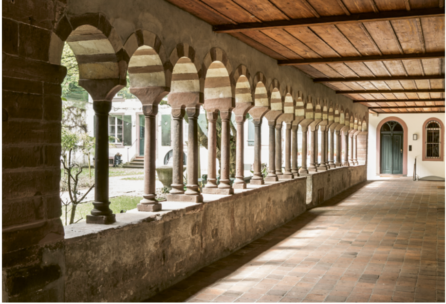
23 Kreuzgang des Klosters St. Alban, spätes 11. Jahrhundert. — Bei diesem Kreuzgang handelt es sich um das einzige noch erkennbare Bauelement des romanischen Klosters.
