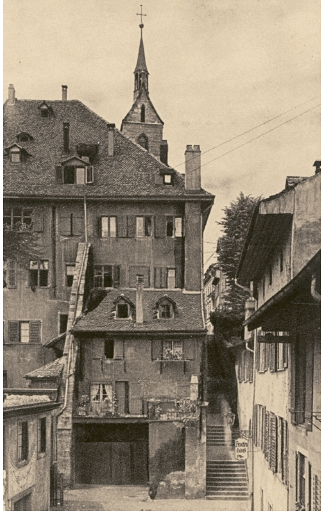
101 Das «Haus Zum Grossen Keller» (ab 1875 «Marthastift»), Zustand um 1921. — Blick auf die talseitige Fassade (Ostfassade) mit dem Eingang zum untersten Keller und den Annexbauten. Die höher liegenden Kellerräume wurden vom Kellergässlein (rechts) aus betreten. Das Gebäude enthält Bausubstanz aus der Zeit vor dem Basler Erdbeben und liegt an einer Schlüsselstelle der Basler Altstadt, am Abhang des Petersbergs gegen den Fischmarkt hin.
