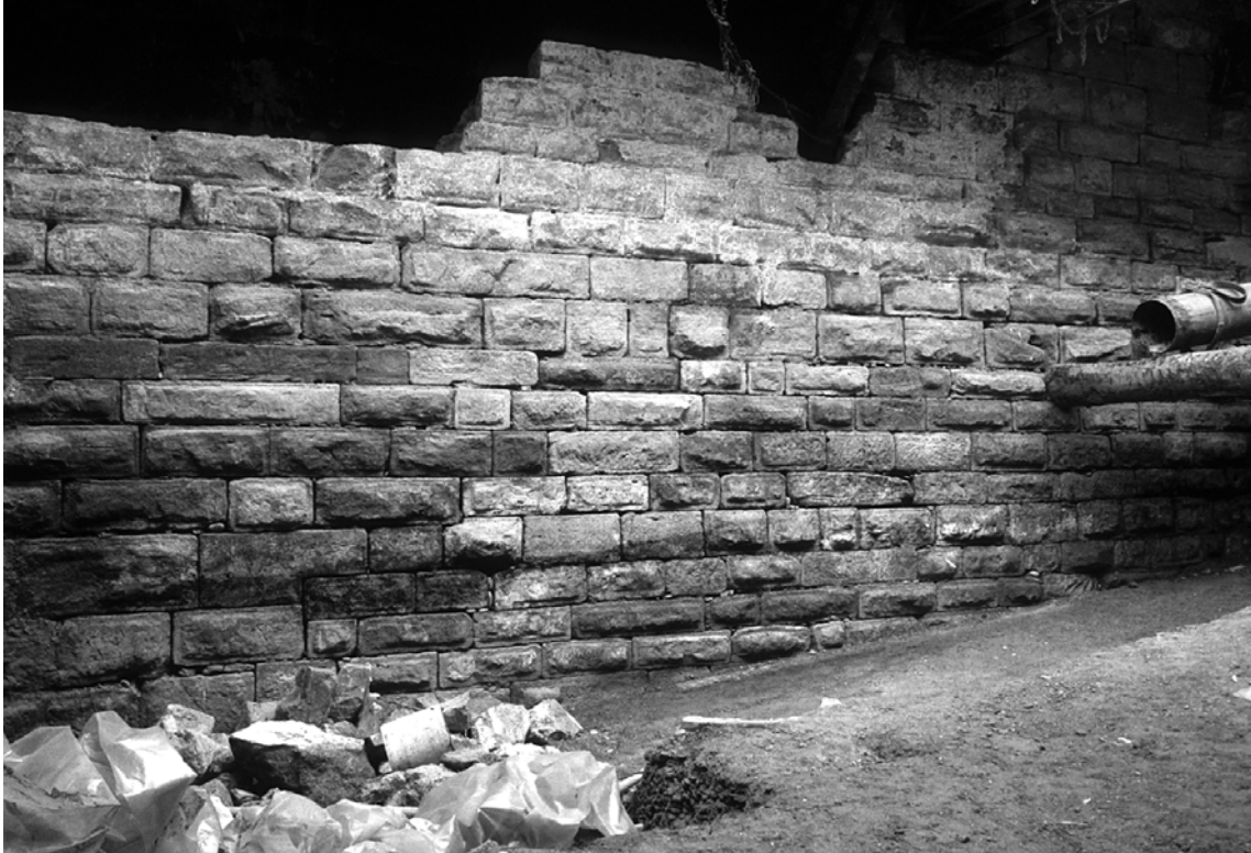
110 Fundament der Inneren Stadtmauer unterhalb der Fassade des Casinos, Steinenberg 10, Aufnahme von 1991. — Der Bereich um den Birsgeinfluss wurde mit Sandsteinquadern verstärkt, um die Bewohnerinnen und Bewohner vor Hochwasser zu schützen.
