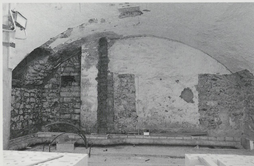
Abb. 4: Der Gewölbekeller des Lohnhofs bzw. ehemaligen Leonhardsklosters am Kohlenberg 20. Ansicht des südlichen Abschlusses, teilweise freigelegt (Foto MC 3–9, Basler Denkmalpflege). Der Stützpfiler ist eine Ergänzung des ausgehenden 19. Jahrhunderts. Links dahinter konnte die originale Zugangstreppe freigelegt werden.
