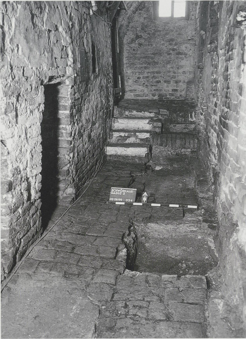
Abb. 4: Heizraum – Blick von Süden nach Norden. Von einem schmalen, gewölbten Gang – dem ursprünglichen Heizraum – wurden die Kesselöfen der unmittelbar östlich gelegenen eigentlichen Garnsiede betrieben.
