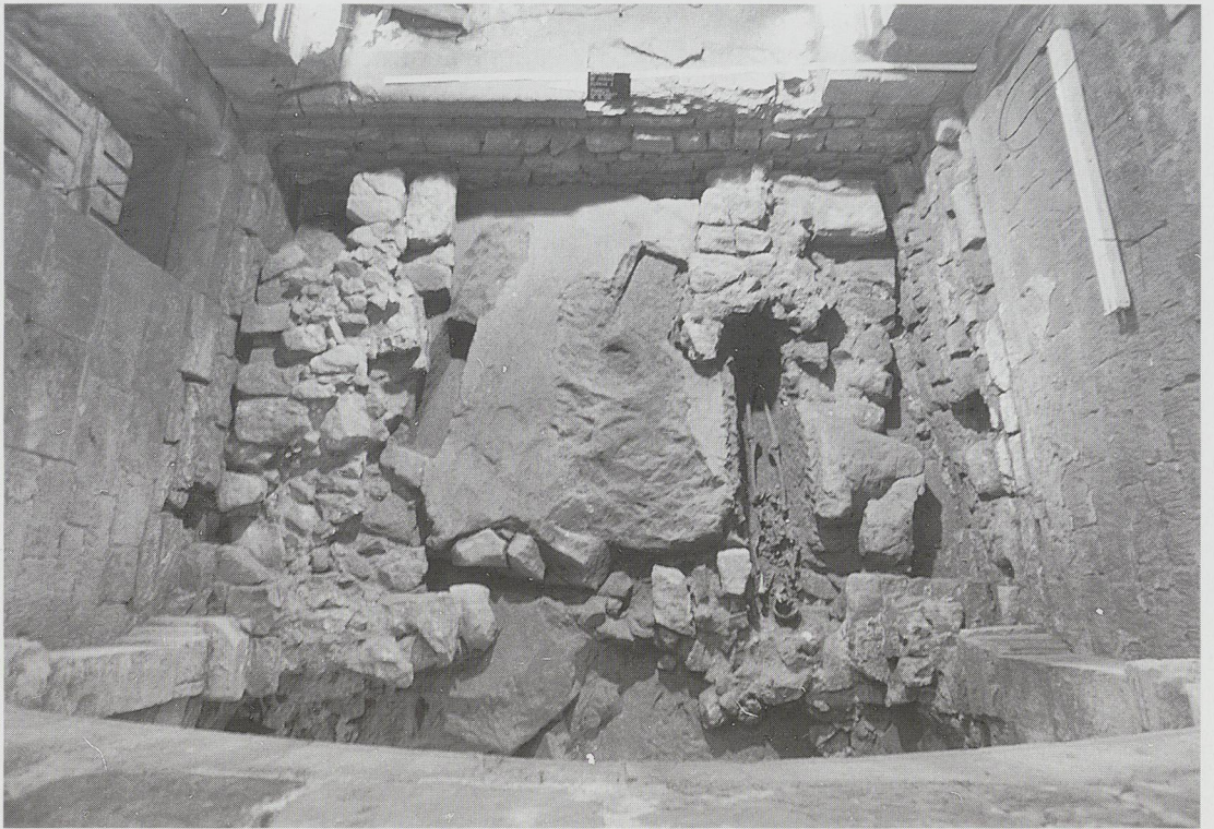
Abb. 4: Aufsicht auf die Fundamente im Langhaus der Stiftskirche (P. Heberer).
