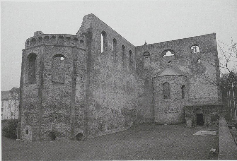
Abb. 1: Ostbau und Querhaus der ehemaligen Klosterkirche Hersfeld von Nord-osten.
