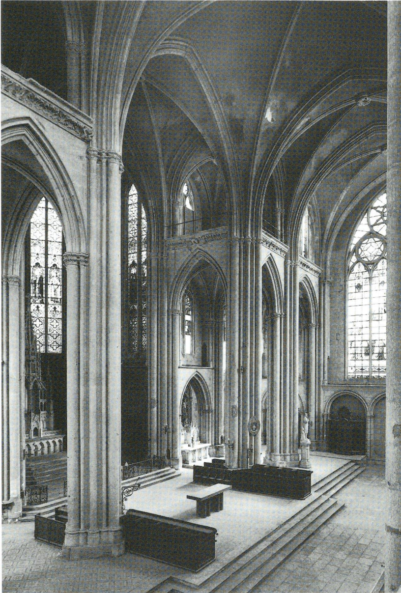
Abb. 1: Metz, Benediktinerabteikirche St-Vincent (1248–1254): Blick in Chor und Querhaus.
