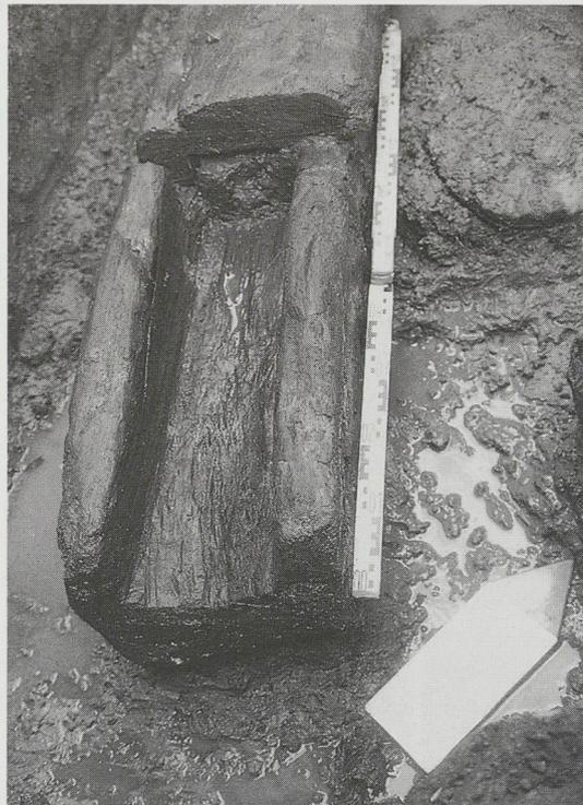
Abb. 2: Romrod (D), Holzdrainageleitung von 1181 (Foto: Verf.).
