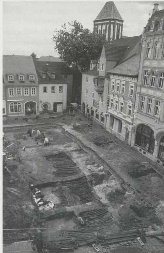
Abb. 3: Senftenberg, Landkreis Oberspreewald-Lausitz. Holzdrainage am Ostrand des Marktplatzes (Foto: M. Agthe).
